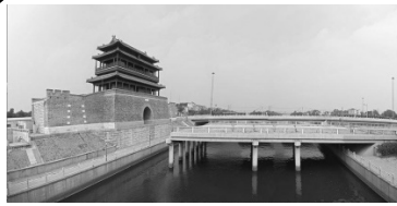
图 a 2004 年正在修建的中的永定门城楼及护城河侧影
